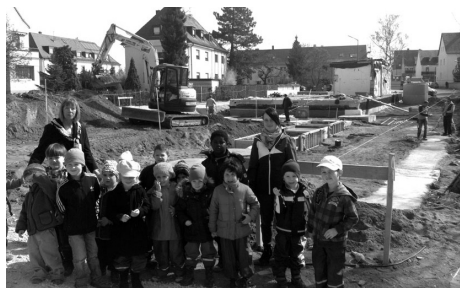
Regelmäßige neugierige Besucher der Baustelle sind unsere Kindergartenkinder. Gespannt verfolgen sie den Baufortschritt.
