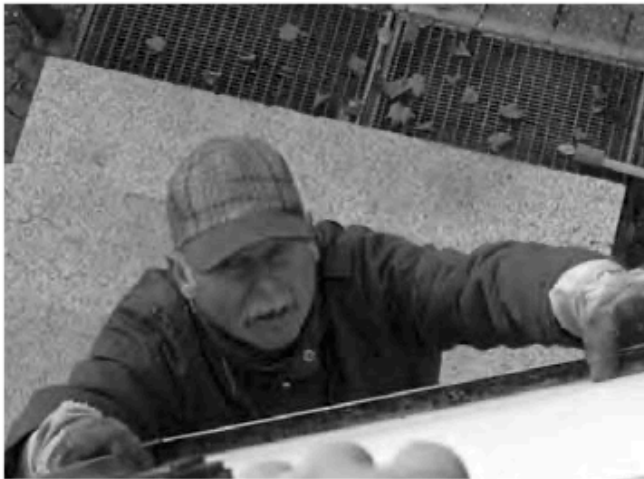
Herr Decker beim Austausch der defekten Solarmodule auf den Gemeindehaus.
